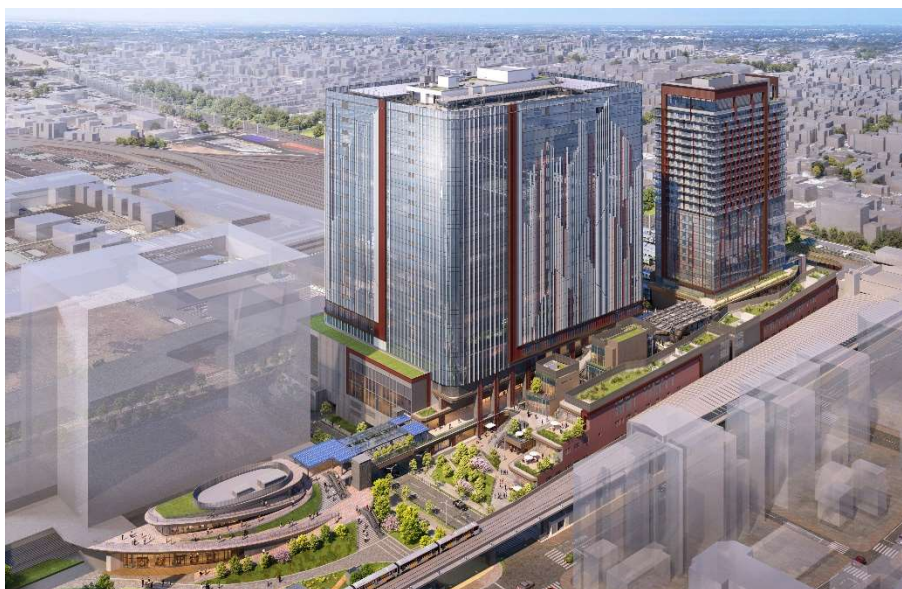
※「OIMACHI TRACKS」外観イメージ
